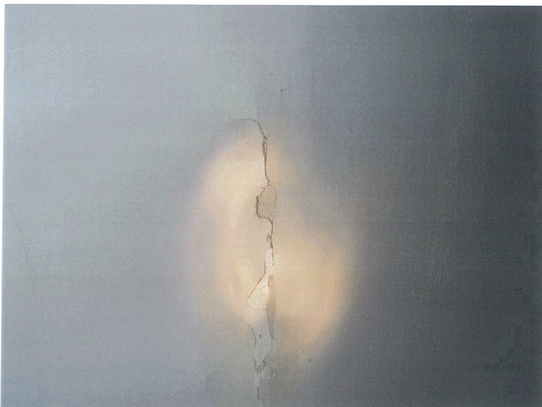
Fot. 75 Pęknięcie pionowe ściany przez które penetruje woda
