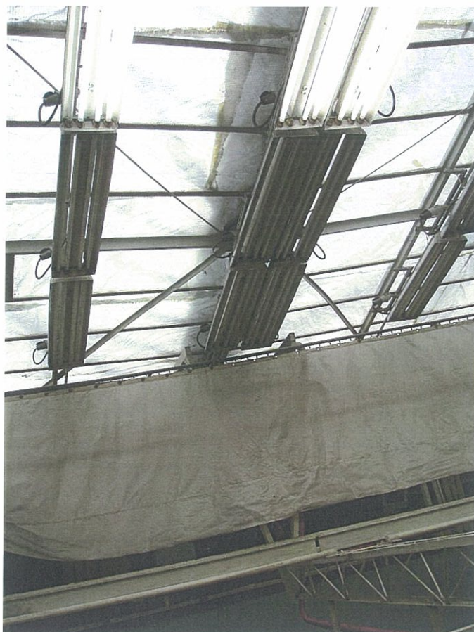
Fot.14 Wyboczony pręt stężenia połaciowego typu „X”
