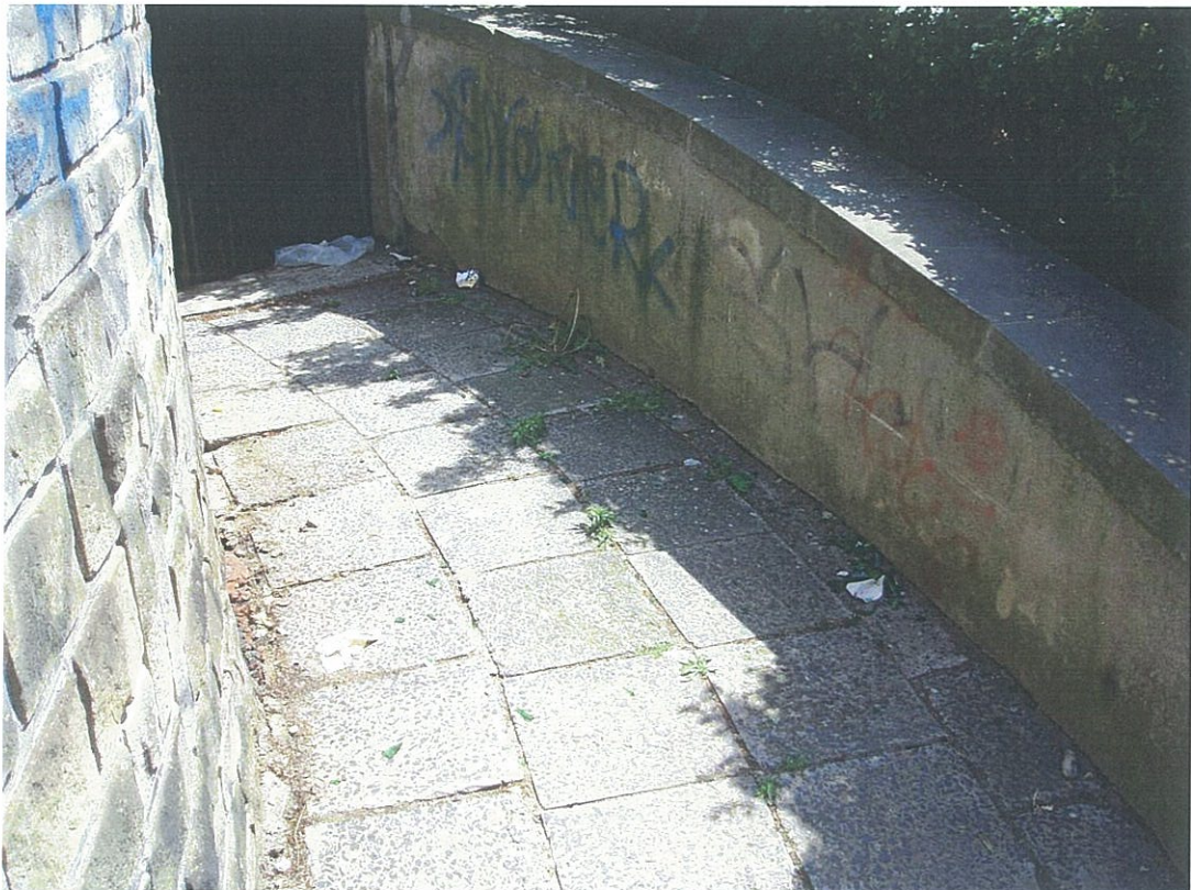
Fot.42 Schody wyjściowe korytarzyka z podziemi budynku rotundy
