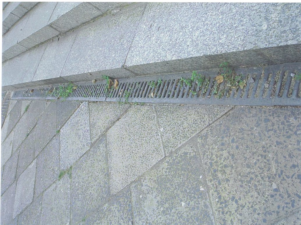
Fot. 49 Zatkane odprowadzenie wody opadowej typu ACO-DRAIN
