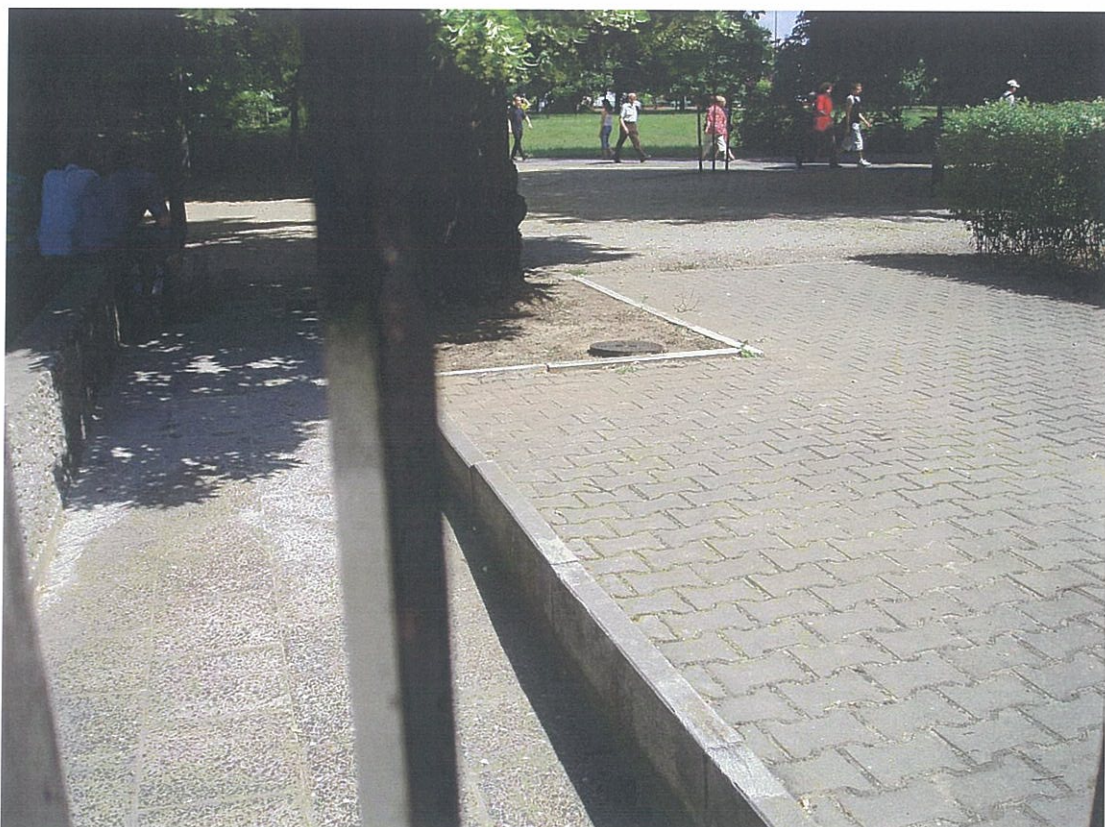
Fot.87 Studzienka wodna, która spowodowała osiadanie budynku
