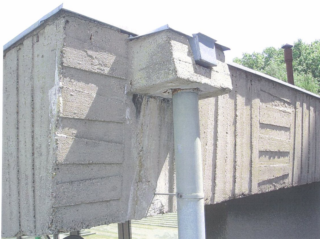
Fot.59 Wymywanie tlenku wapnia z betonu przy koszu rury spustowej
