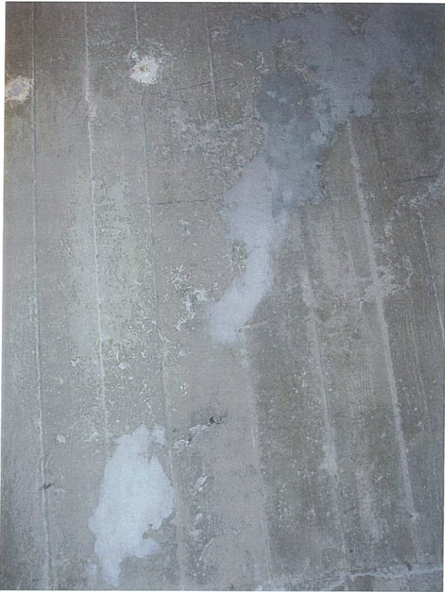
Fot. 37 Ślady „zacierek” spękań
