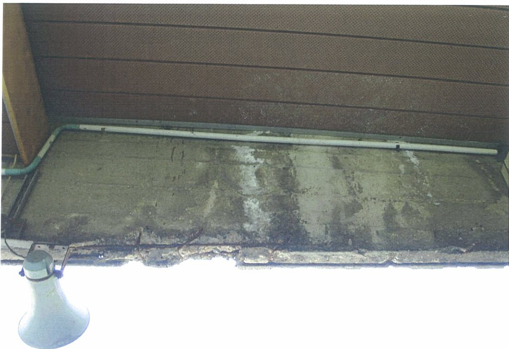
Fot. 51 Stan krawędzi żelbetowej ściany elewacyjnej nad głównym wejściem do obiektu Panoramy Racławickiej
