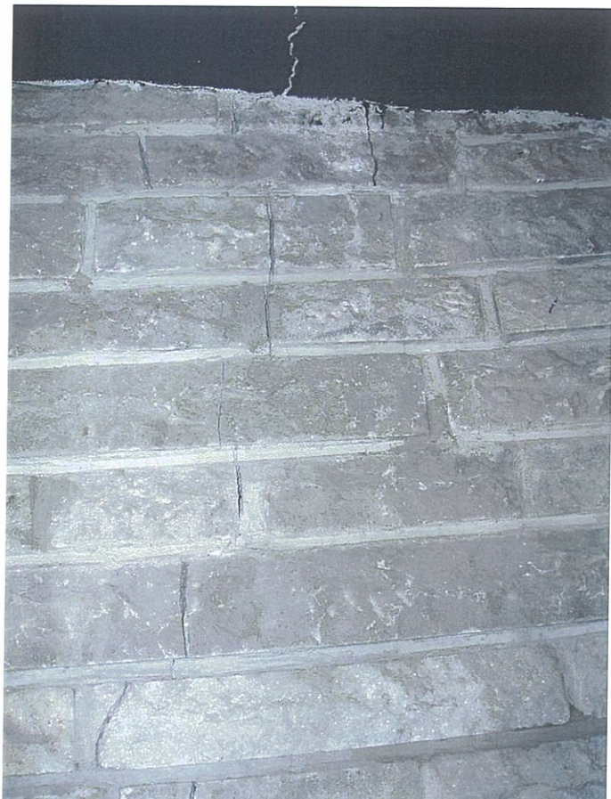
Fot. 32 Pęknięcia wykładziny kamiennej na zdylatowanej ścianie korytarza na platformę widokową rotundy
