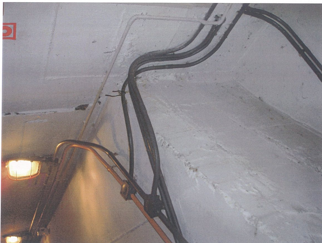
Fot. 89 Zacieki nad przewodami elektrycznymi
