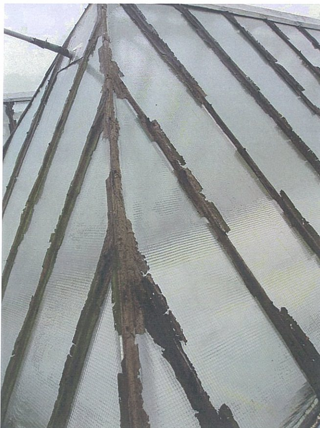
Fot. 5 Widok taśm uszczelniających od czoła świetlika
