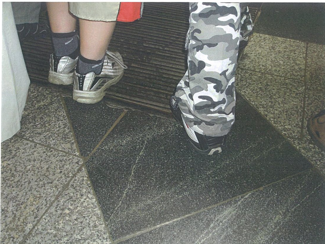
Fot.61 Widok kraty studzienki w posadzce „małej panoramy”
