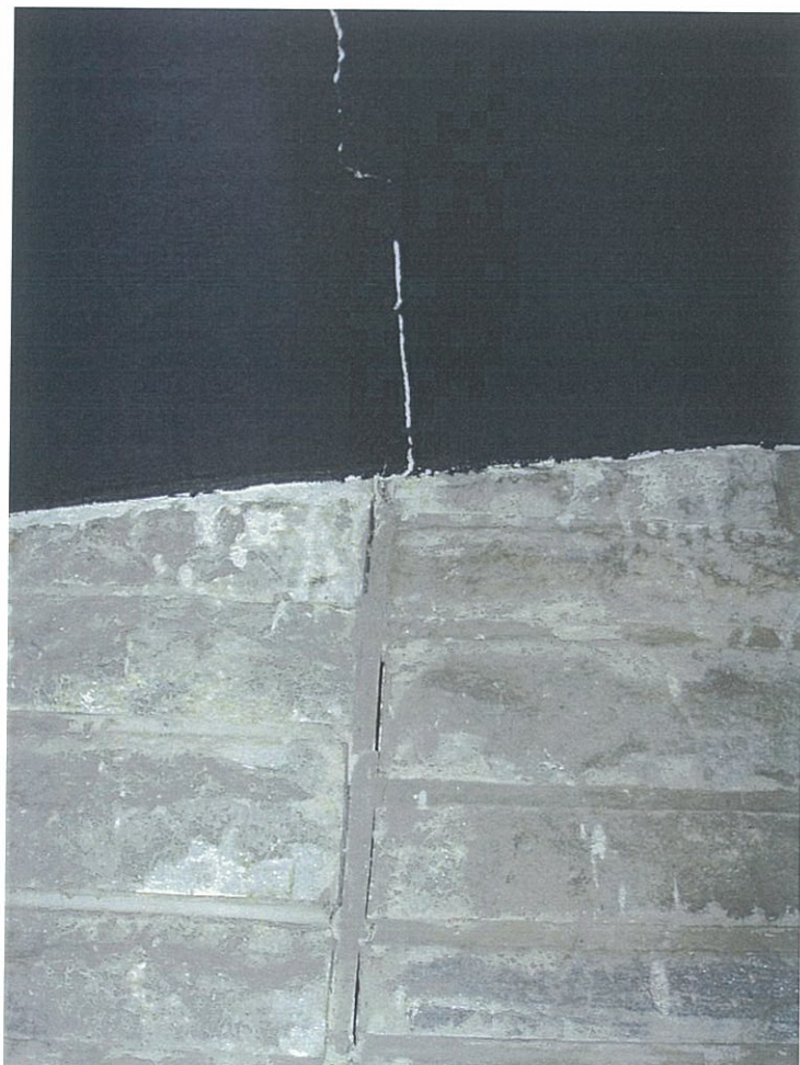
Fot. 32 Pęknięcia wykładziny kamiennej na zdylatowanej ścianie korytarza na platformę widokową rotundy
