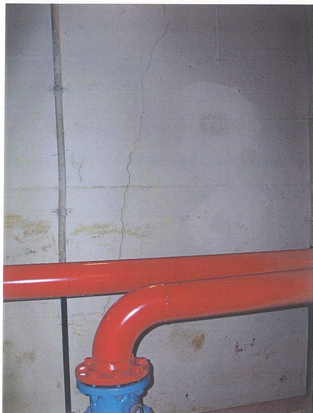
Fot. 89 Zacieki nad przewodami elektrycznymi
