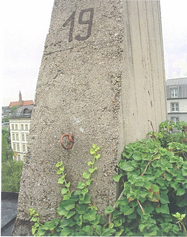
Fot.17 Powierzchnie betonu słupów
