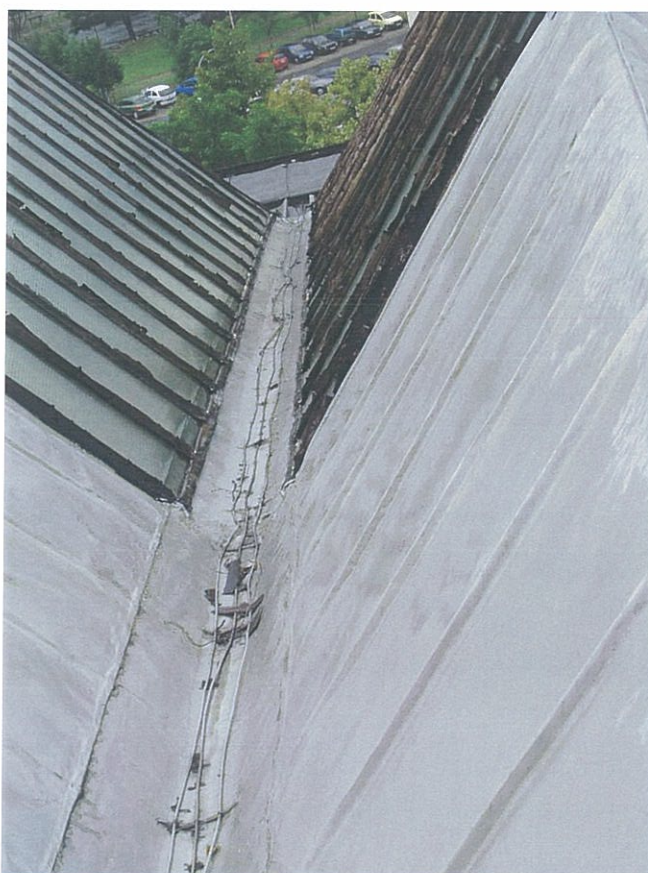
Fot. 2 Detale pokrycia dachowego z blachy miedzianej
