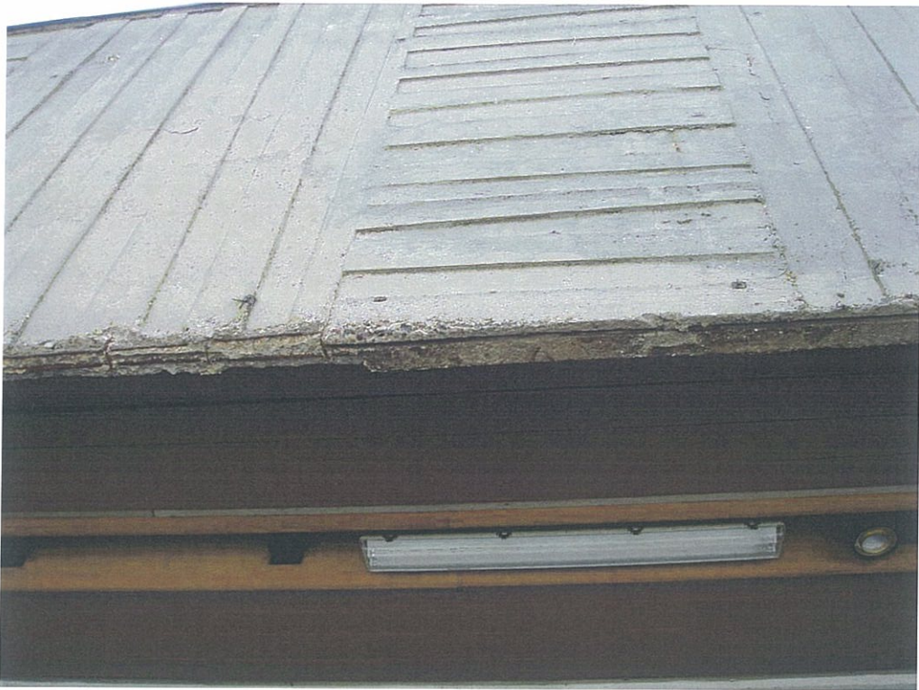
Fot. 51 Stan krawędzi żelbetowej ściany elewacyjnej nad głównym wejściem do obiektu Panoramy Racławickiej
