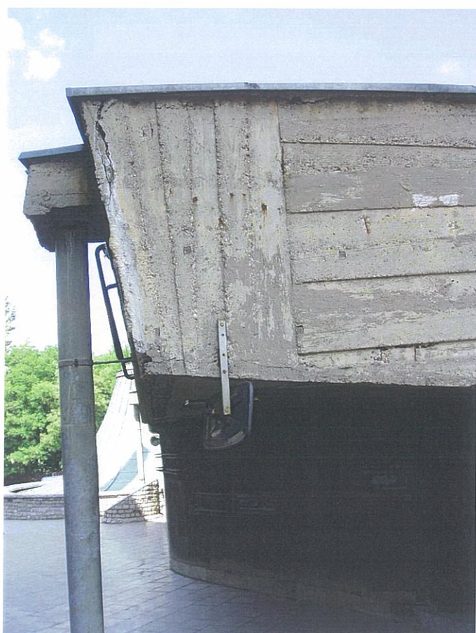
Fot.59 Wymywanie tlenku wapnia z betonu przy koszu rury spustowej
