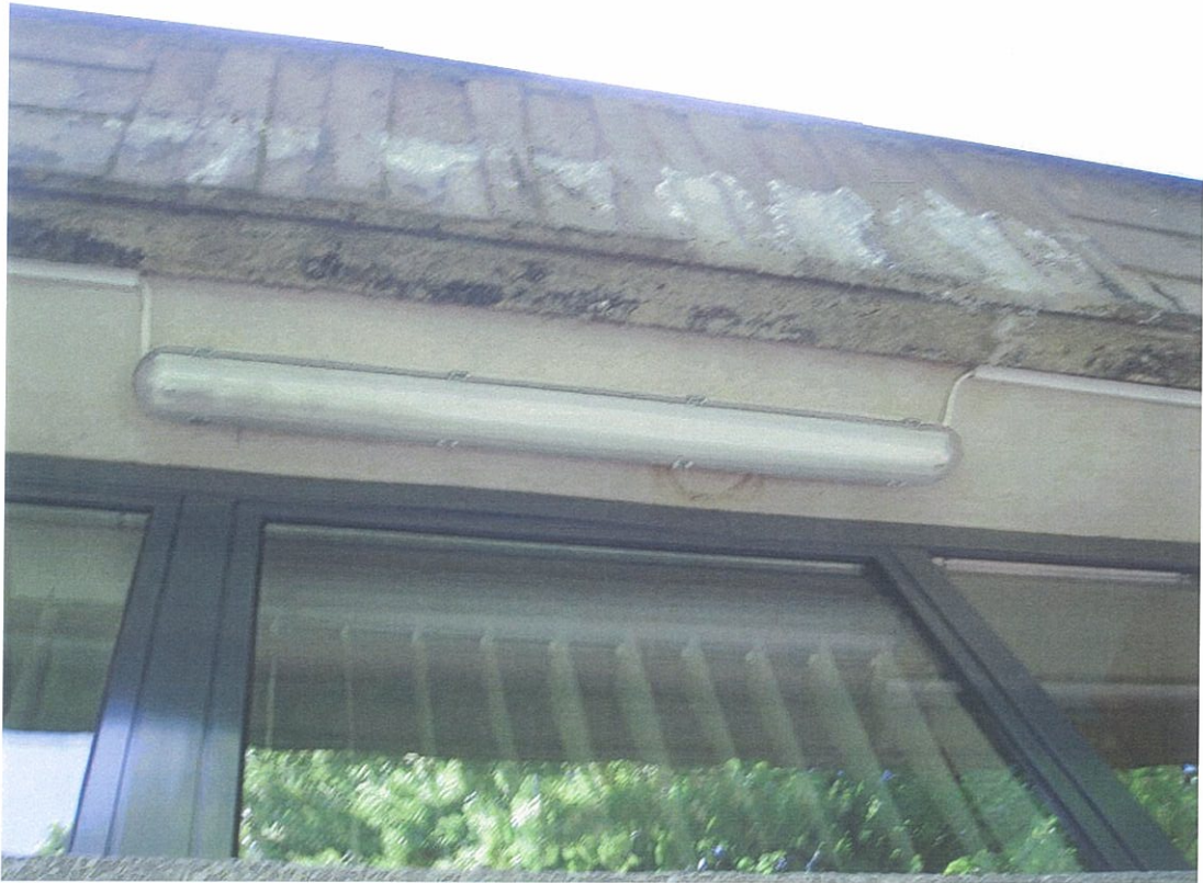
Fot. 57 Zbliżenie wykwitów węglanu wapnia na żelbecie attyki od wschodu
