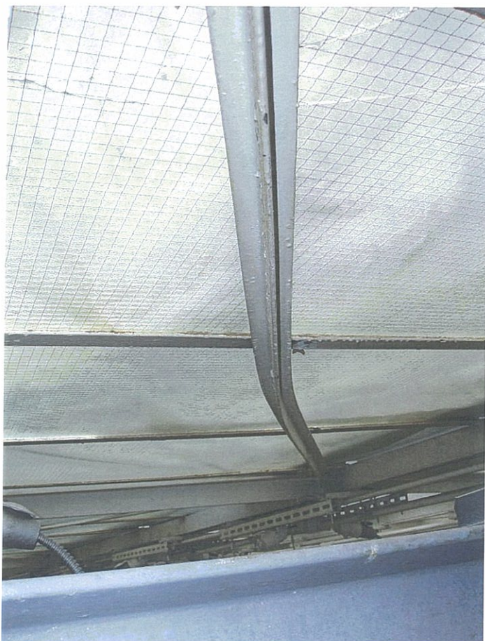
Fot.14 Wyboczony pręt stężenia połaciowego typu „X”
