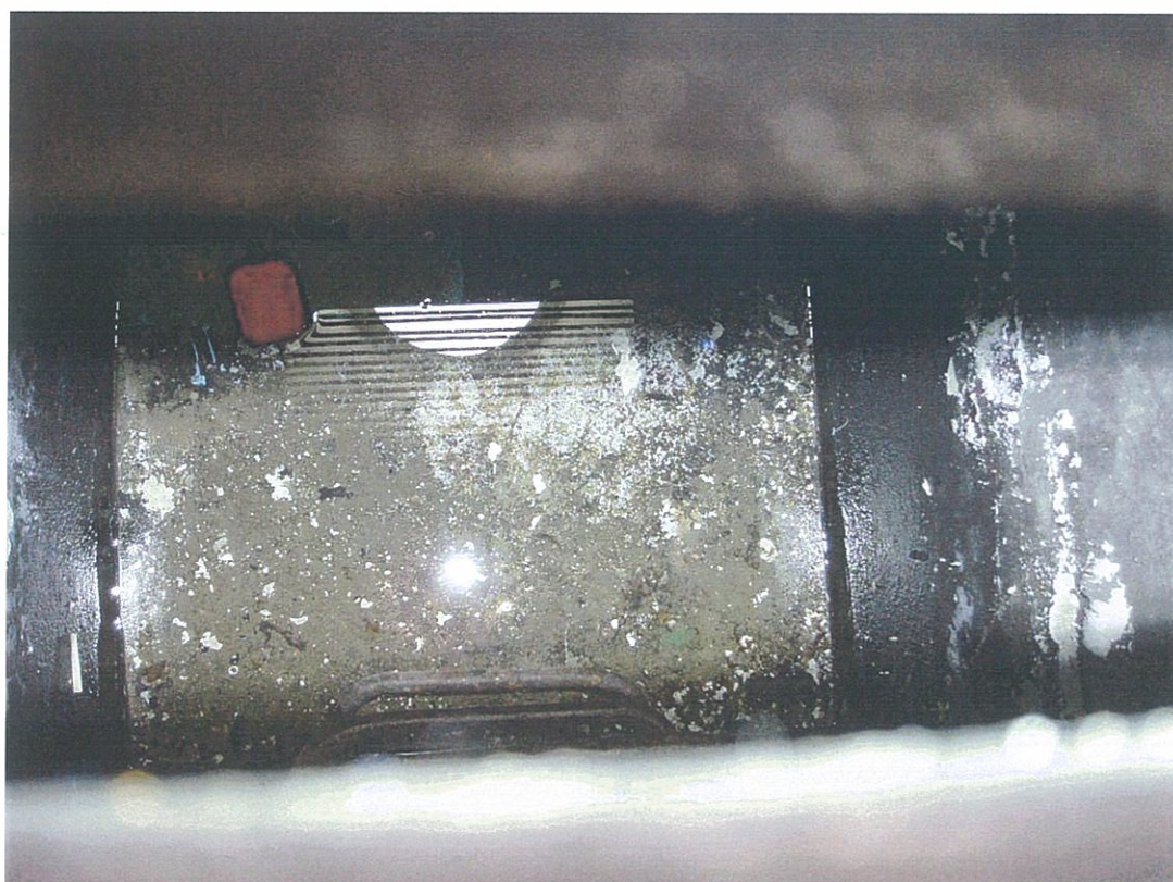
Fot.62 Woda gromadząca się na dnie studzienki
