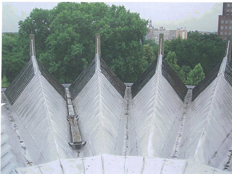
Fot. 1 Widok pokrycia dachowego z grzybka dachu
